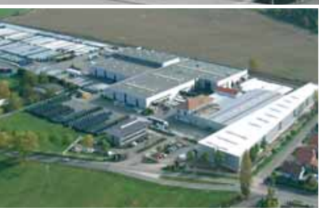
Site de production historique de Dachstein en Alsace
